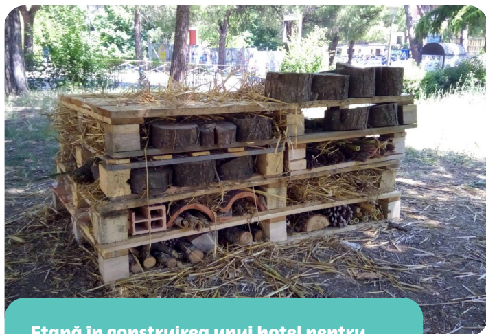
Etapă în construirea unui hotel pentru insecte în grădina Direzione Didattica 2 „Comparozzi” (Perugia-Italia)
